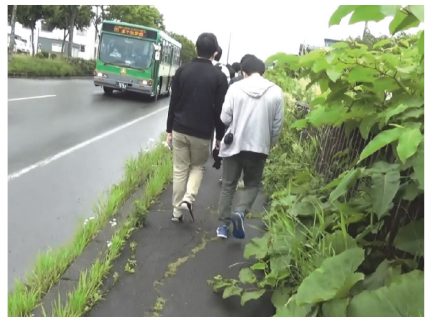
図 10 歩道脇の植物繁茂の一例
