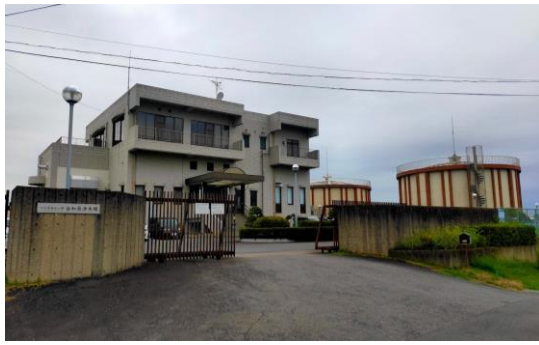
図 9 つくばみらい市谷和原浄水場 (2022年8月29日撮影)
