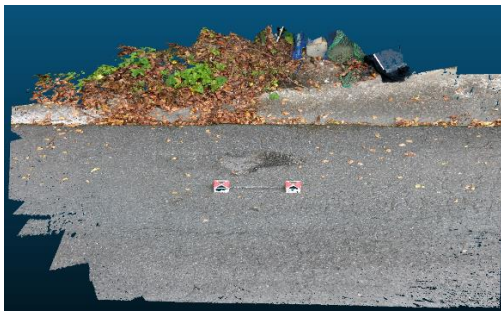
図-8 ポットホールの3次元点群データ
