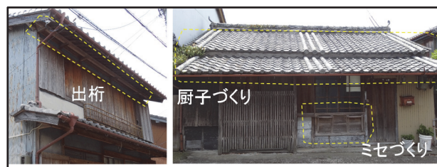
図-4 出桁、厨子づくり、ミセづくりの例
