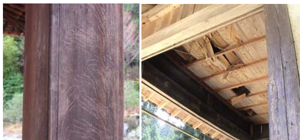
図-1 アライグマによる社寺被害の実例 左図：爪痕による柱の被害、右図：建造物への侵入による天井板の破壊被害
