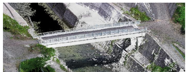
図-4 童子畑橋での地上型レーザスキャナとUAVによる3次元点群データ
