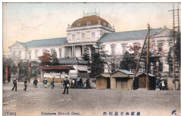
図-2 横浜地方裁判所前の様子
