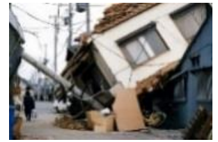
図-3 道路閉塞時の写真 (人と防災未来センター)
