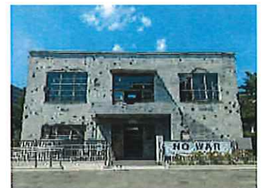
旧日立航空機立川工場変電所 (筆者撮影)
